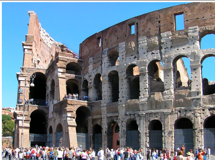
Na tomto obrázku je dobře patrné, jak byly dvě vnější zdi v části obvodu úplně rozebrány. Foto: F. Slípka
