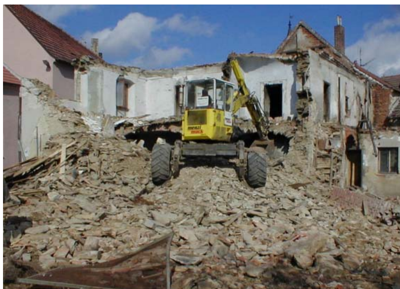
Obr.6– Demolice rodného domu J. V. Kamarýta ve Velešíně v roce 2001 / zdroj: www.pratelevesina.cz/
